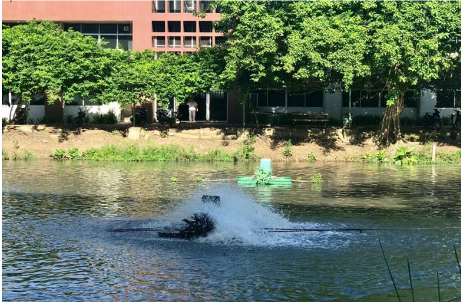
รูปที่ 12 ระบบบำบัดน้ำเสียแบบปอดเติมอากาศ (Aerated Lagoon หรือ AL)
